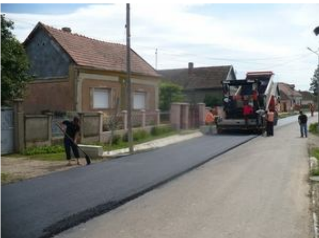
A HEGYKÖZCSATÁRI KIS UTCÁBAN HELYEZIK FEL AZ ÚTTESTRE A KOPTATÓ BÚRKOLATOT
